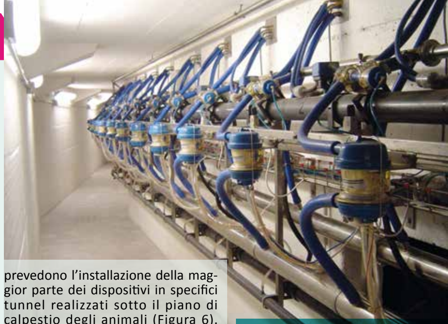
Figura 6 L'installazione di una parte della componentistica degli impianti in tunnel realizzati sotto il piano di calpestio degli animali libera la fossa permettendo al mungitore di muoversi con più agilità
